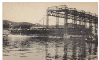
ガントリークレーンより陸奥の進水式(大正7年)
