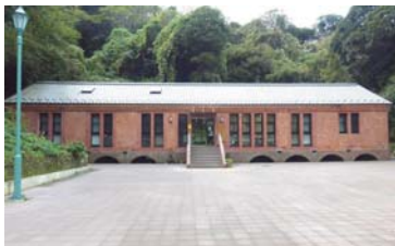
観音崎パークセンター外観
