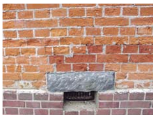
建設当時のレンガを修繕し使用
